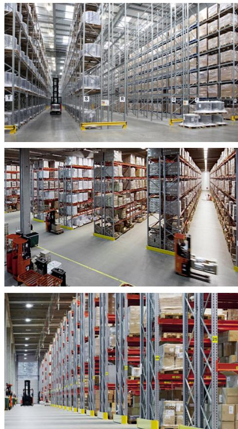
P90 i standardutförande ger obegränsad åtkomst till alla lagrade pallar och är lämplig för all slags lagring utan något begränsande system för pallplacering.
